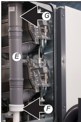
Rookgasafvoerpijp uitbouwen Figuur 12.3.b
